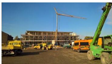
Der Neubau ist in vollem Gange
