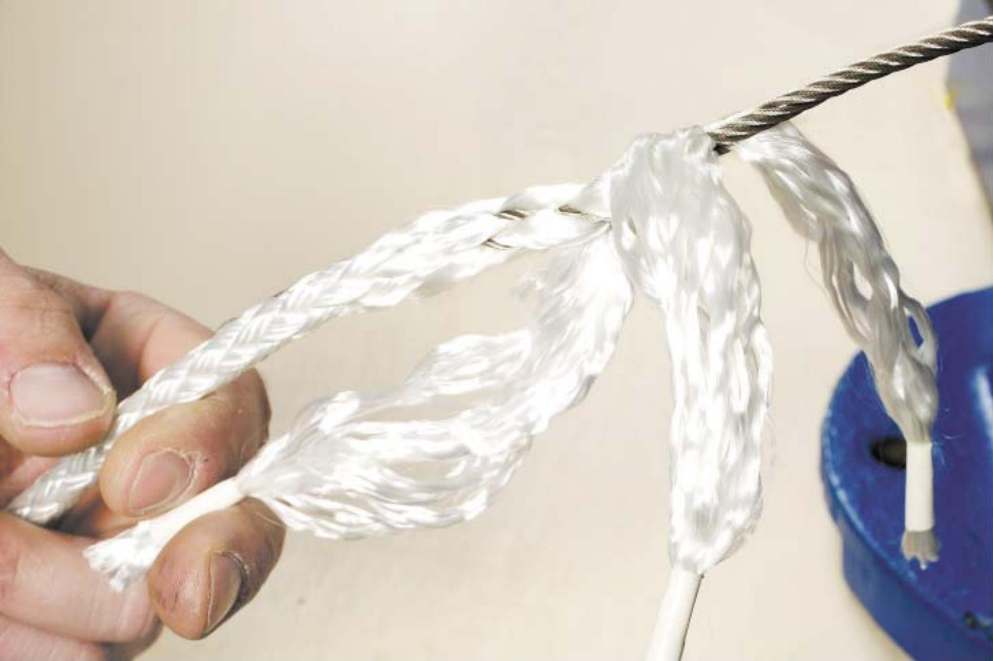
Rundstich komplett ausführen. (Jede Litze über 2 und durch 2 Drahtlitzen hindurchstecken.) Es müssen mindestens 3 komplette Rundstiche durchgeführt werden.
